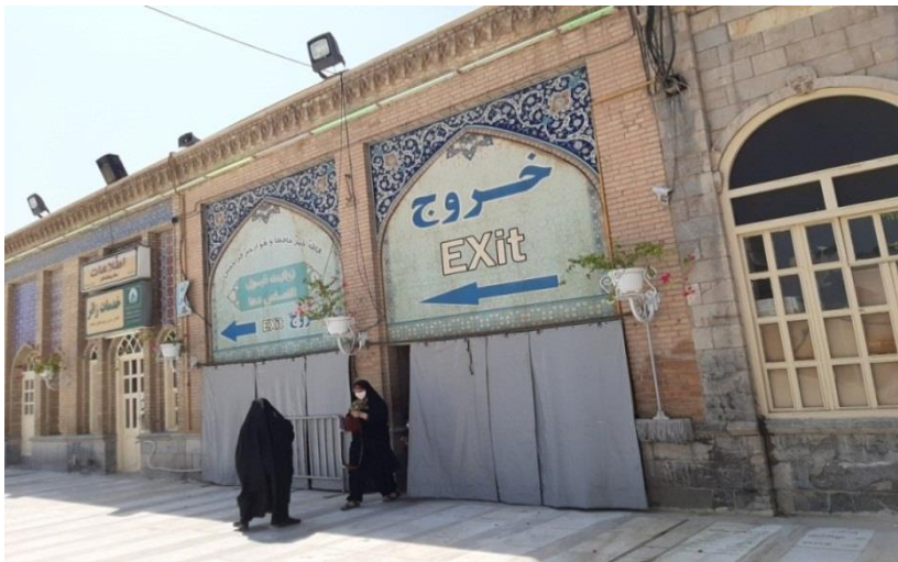
درهای ورودی زنان زائر به زیارتگاه که از بیرون و داخل پوشیده شده‌اند.
